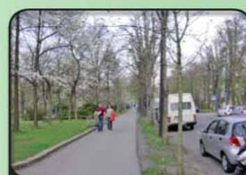
MARIA-THERESIA-ALLEE Straßensanierung mit Verbreiterung des Grünstreifens und Neuorganisation der Stellflächen.
