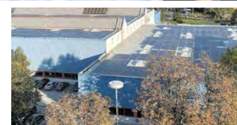
Die neue Photovoltaikanlage auf rund 14.000 Quadratmetern Dachfläche.
