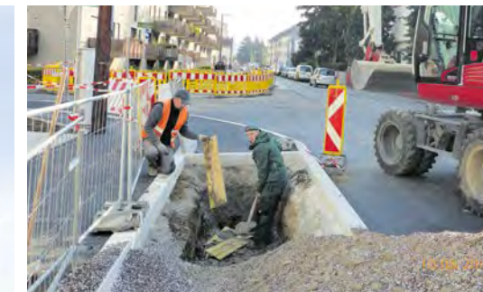
Tiefschürfende Erkenntnisse. Um den neuen Bäumen beste Bedingungen zum Gedeihen zu verschaffen, wird nach dem „Stockholm-System“ ein Schwammsubstrat im Boden verlegt.
